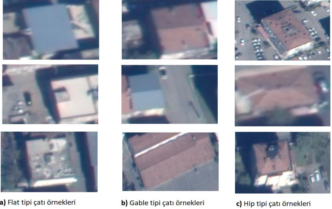
Şekil 2.10: Uygulama alanında bulunan çatı tipi örnekleri
