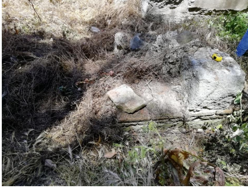
Fotoğraf 5: Türbe Güneydoğu Duvarı Ayrıntı (2019).
