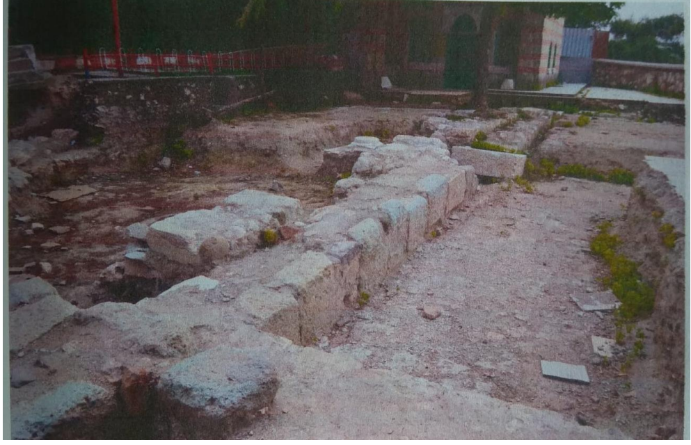
Fotoğraf 17: Caminin Temel Duvarlarında Kullanılan Bosajlı Taşlar(B.A.K.K. 2017).
