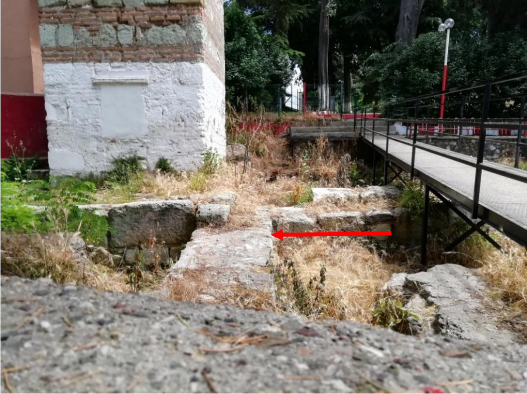
Fotoğraf 12: Minarenin Kaidesine Saplanan Kuzeybatı Duvarı (2019).
