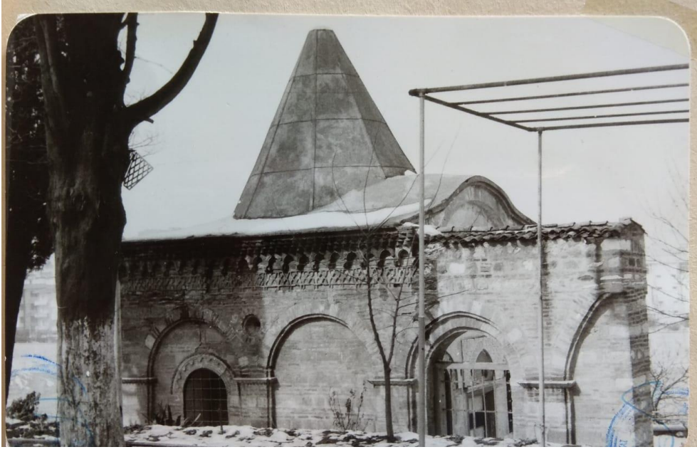
Fotoğraf 29: Türbe, Onarım Sonrası Kapatıldığı Düşünülen Kemer (1948) (B.A.K.K. 2017).
