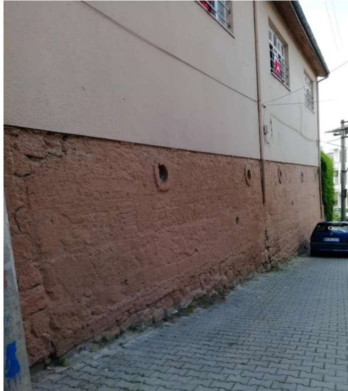
Fotoğraf 6: Kirmasti L. Ş. P. Külliyesi İstinat Duvarı (2019).
