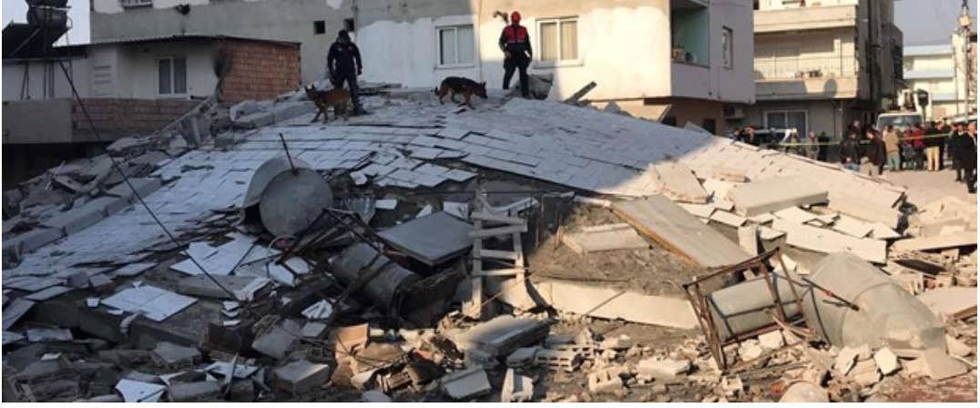
Şekil 2.6 : Mersin’de çöken bina – 2019 [64].
