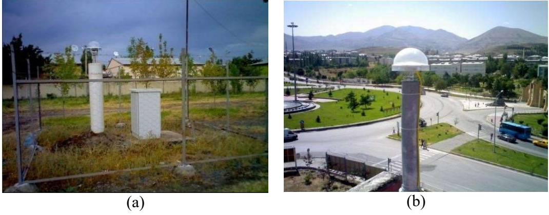
Şekil 5.11: TUSAGA-Aktif istasyonları a) Beton yer pilyesi, b) Çelik pilye [77]
