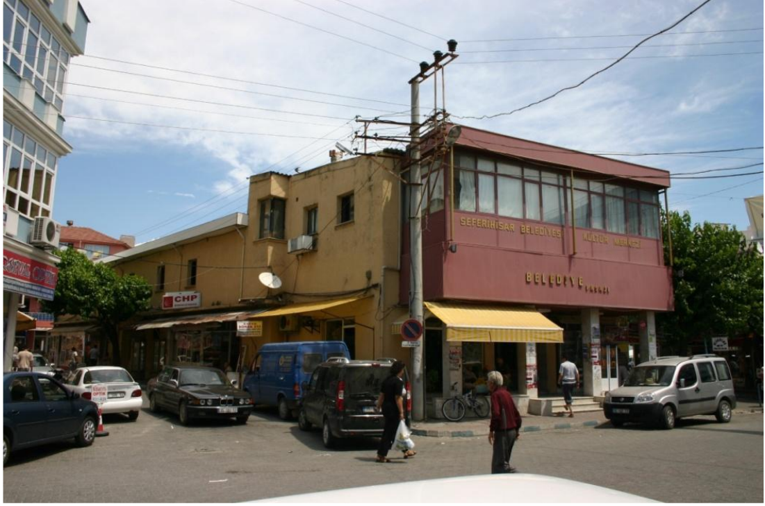
Şekil 4.7: Eski Belediye Pasajı yenileme öncesi (Doğutürk, 2010)
