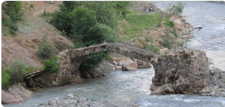
Şekil 3.12: Meydancık taş kemer köprüsü (Şavşat Belediyesi, 2017a)
