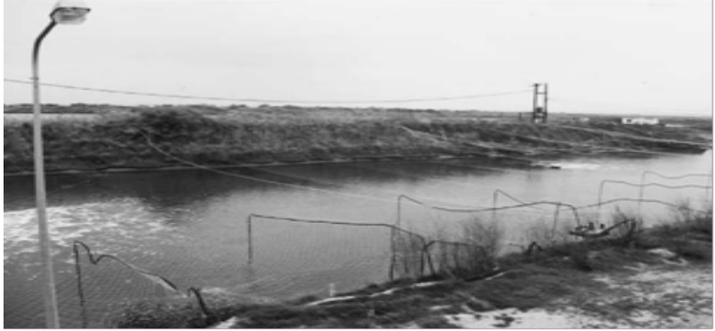
Şekil 7. Porto Lagos Balık Kışlatma Kanalı
