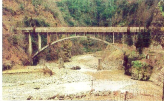
Resim 6. (13) ATSHES – 1937 Binaları Bağlayan Hidro tünelleri
