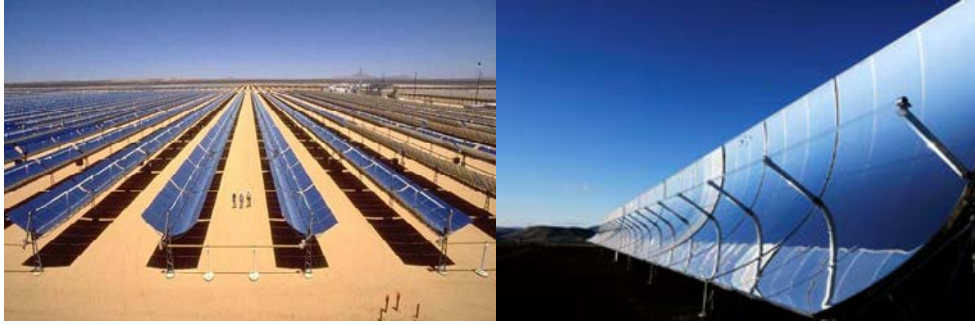
Şekil 6. Parabolik oluk sistemi uygulaması
