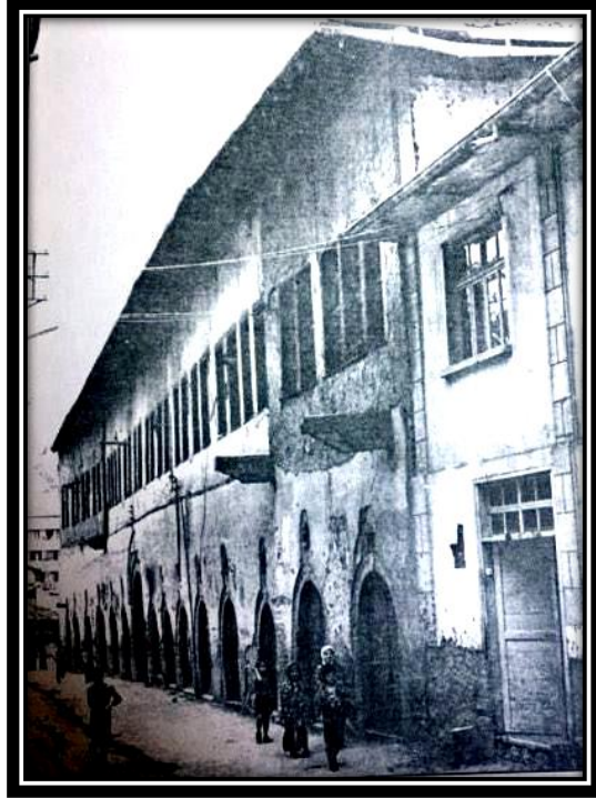
Resim 13: Tokat'ta boyahane olarak kullanılan hanın giriş cephesi
