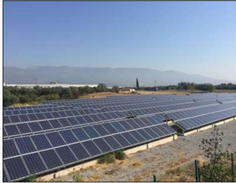
Şekil 4.3 : KOSBİ atıksu arıtma tesisi güneş enerjisi paneli görseli.
