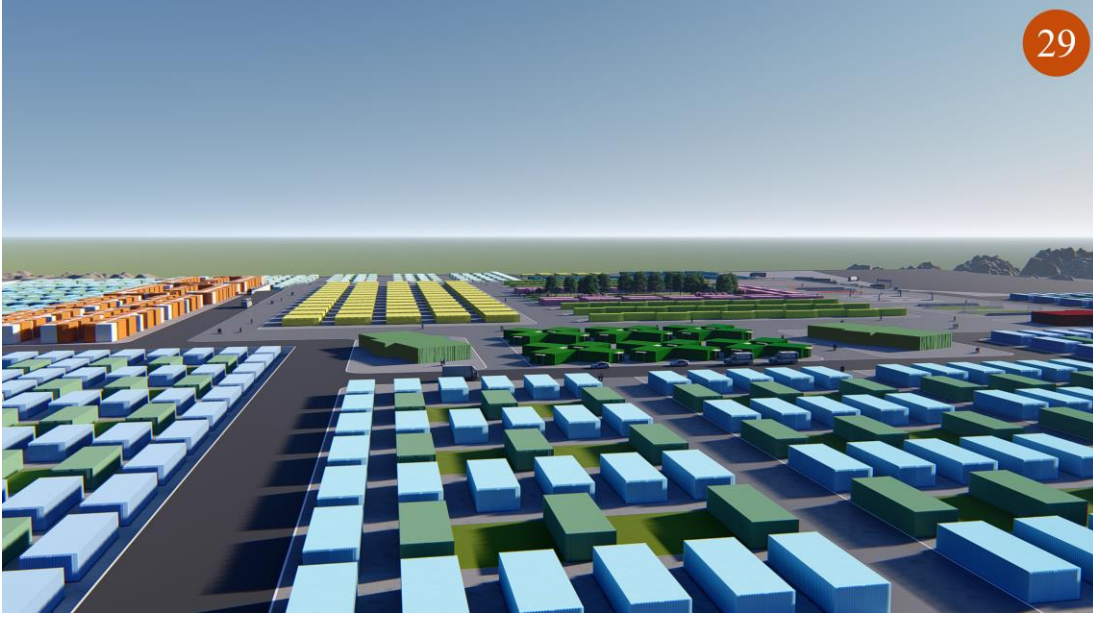
Şekil 4.201 : Konteyner Kent Doğu Cephesi Görünümü.
