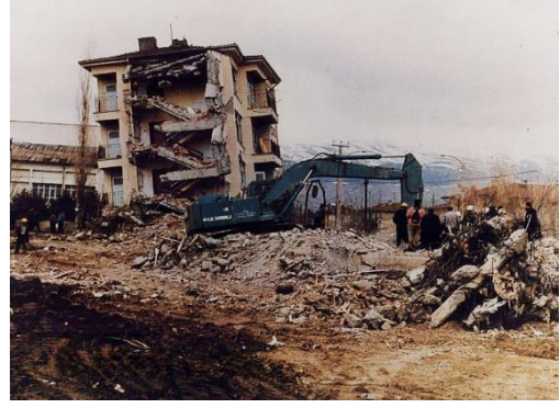
Şekil 2.5 : Erzincan Depreminin Yapılarda Meydana Getirdiği Hasar [17].
