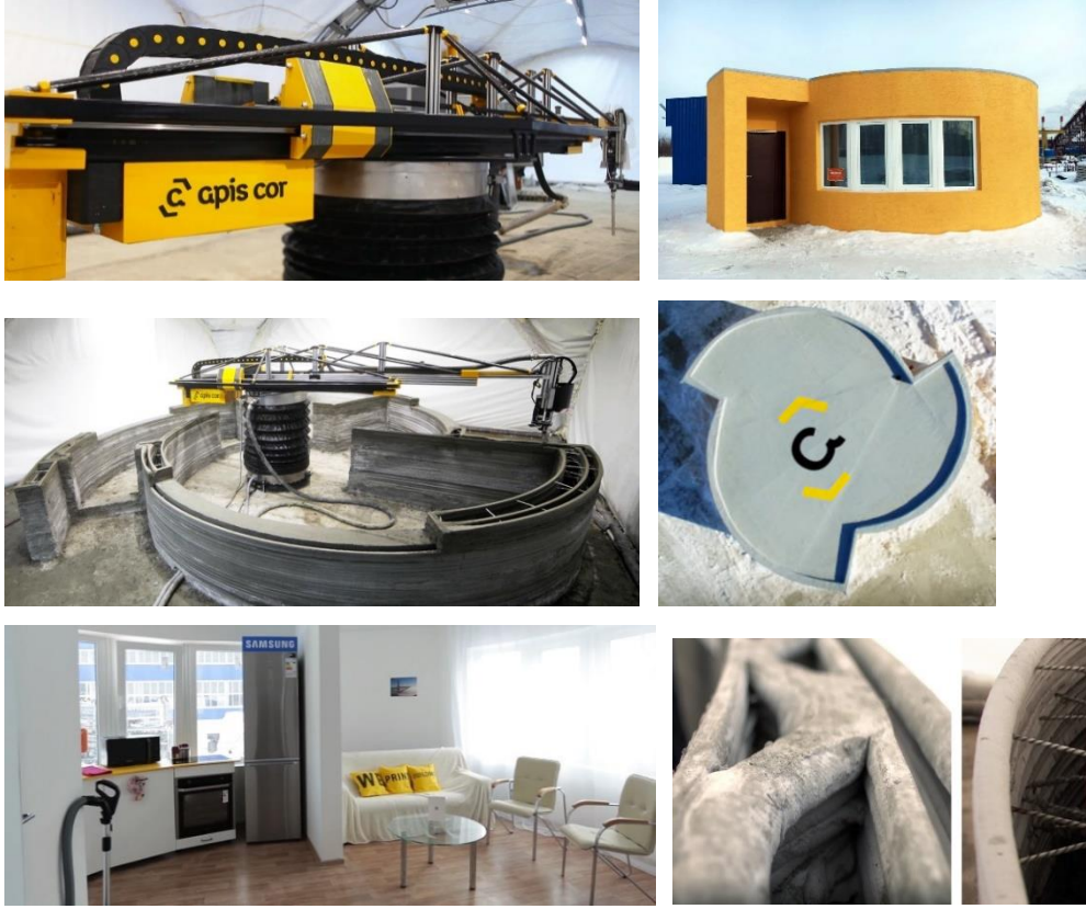
Şekil 3.7 : APIS – COR 3D Yazıcı İle Yapılan Geçici Barınma Birimi [35].
