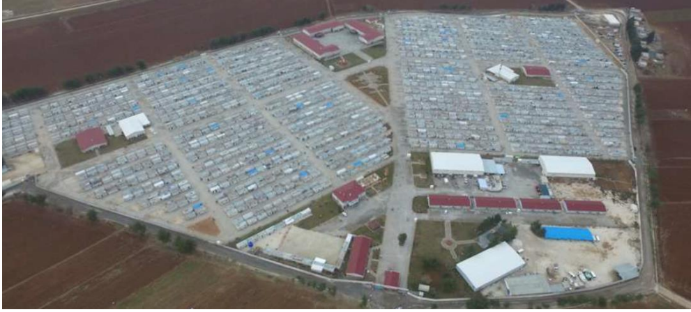
Şekil 4.179 : Şanlıurfa Harran Konteyner Kenti [51].
