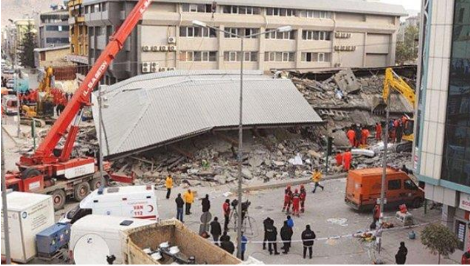
Şekil 2.10 : Van Depremi Sonrası Yıkılan Bayram Otel [27].
