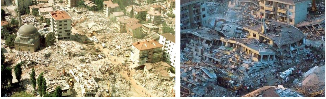
Şekil 2.9 : Gölcük Depreminin Meydana Getirdiği Yıkım [24], [25].
