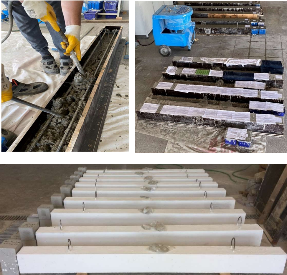
Şekil 9: Beton döküm aşamaları
