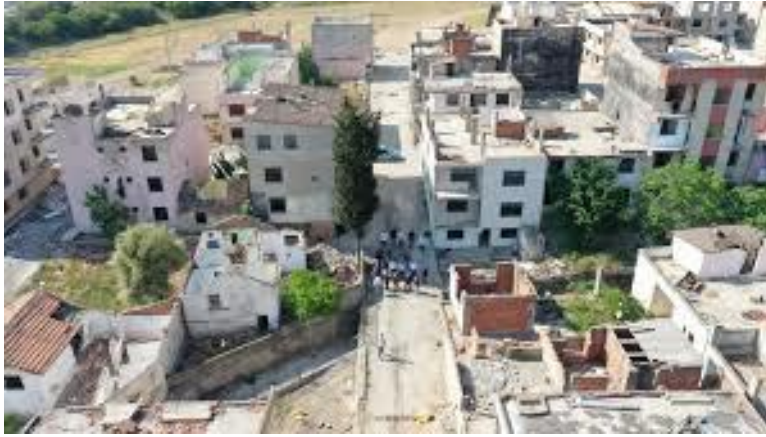
Şekil 6 :Proje için Uzundere'de yıkıma hazırlanmış bir mahalle
