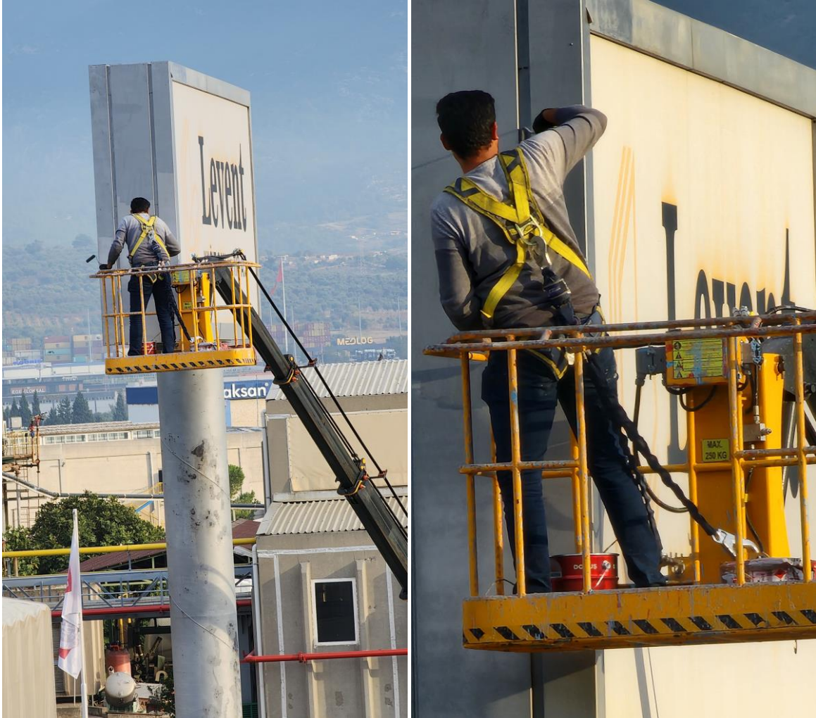
Şekil 3.3: Yüksekte çalışırken yatay yaşam halatı (lanyard) yanlış yere takan bir çalışan
