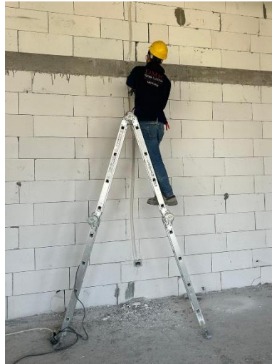
Şekil 3.2: Merdiven üzerinde desant (kazıma) işlemi yapan çalışan
