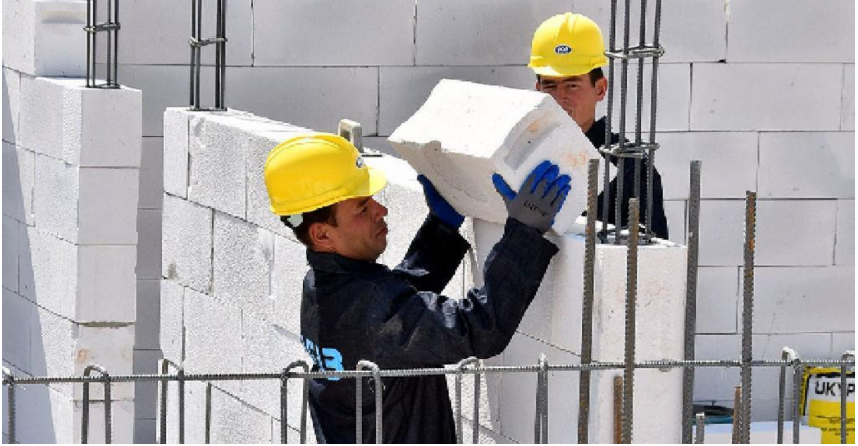
Şekil 3.4: Gaz beton imalatı yapan çalışanlar ve kullanmak zorunda oldukları KKD'ler
