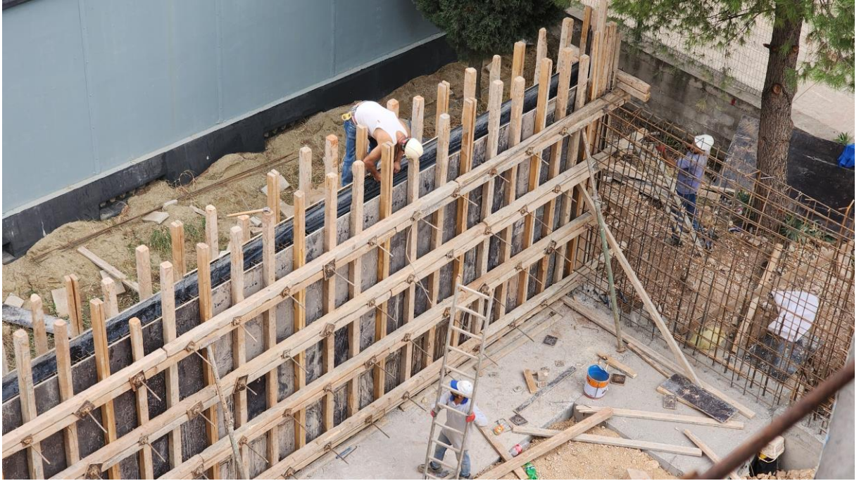
Şekil 3.6: Kalıp üzerinde tehlikeli çalışma yapan bir çalışan
