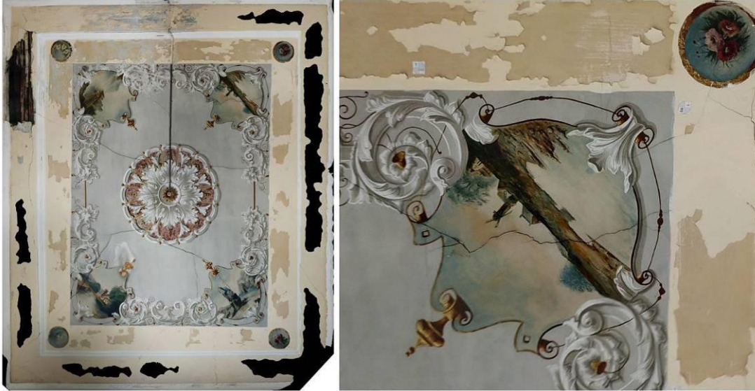
Şekil 3.26 : Yersel lazer tarama ile detaylı tavan resmi verisi elde edilmesi - Ayvalık konut örneği [48]
