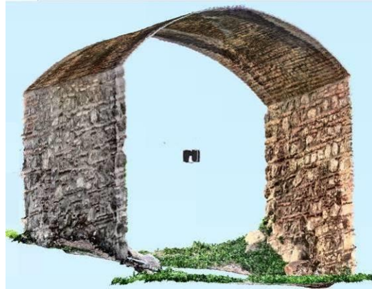
Şekil 3.6 : Renklendirilmiş lazer tarama verisi - Vezirsuyu Su Kemerleri, İzmir [48]
