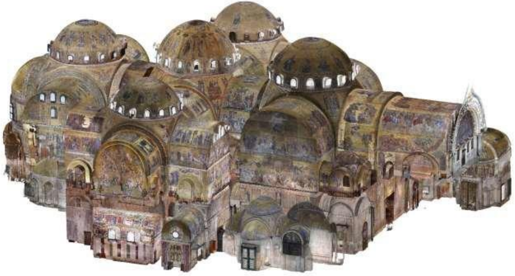
Şekil 2.13 : Yüksekliği nedeniyle erişilemeyen kubbelerin belgelenmesinde yersel lazer tarayıcı kullanılması - San Marco Bazilikası, Venedik [40]
