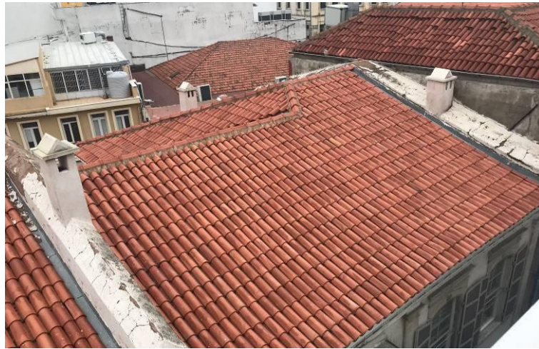
Şekil 4.30 : Ahmet Ağa Konağı - çatı görünüşü
