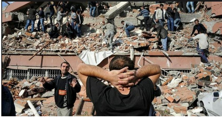
Şekil 2.12 : 2011 Van depreminde yıkılan bina [32].
