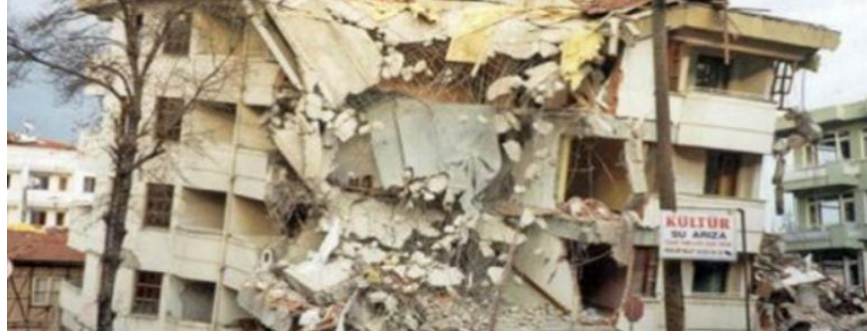
Şekil 2.11 : Korozyona karşı önlem alınmadığından dolayı 1999 depreminde yıkılan bir bina [30].
