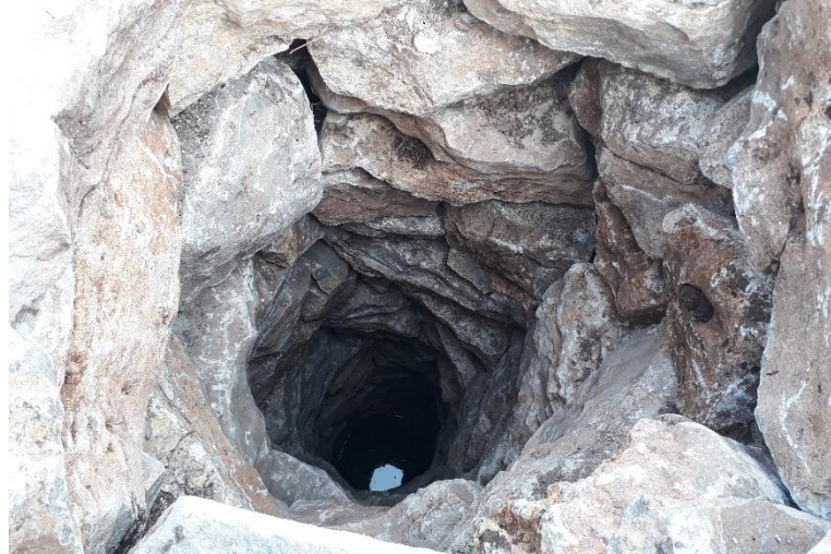
Fotoğraf 251: Örmesi (yapımı) tamamlanan su kuyusu.
