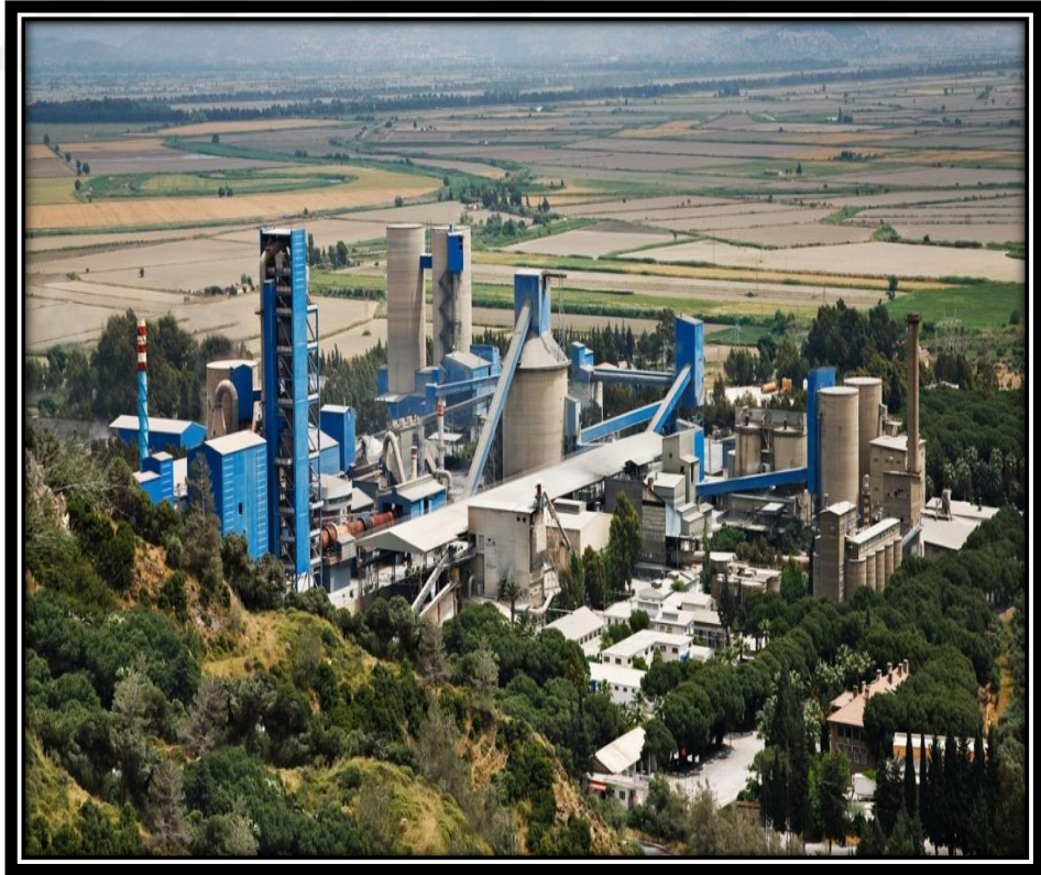
Şekil 2.6 : Çimento fabrikası genel görünüm.
