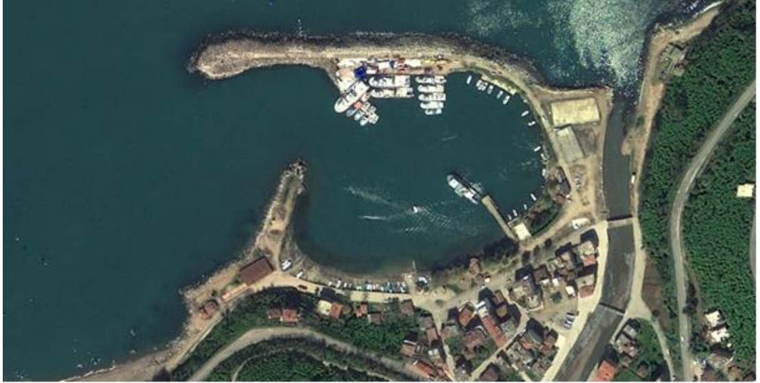
Şekil 2.2: Yalıköy balıkçı barınağı genel görünümü.
