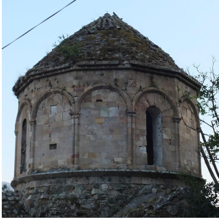
Resim 15:Hamamlı Dolishane Kilisesi Kubbe Kasnağı (G.Tiryaki, 2017)
