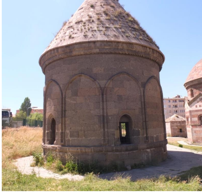
Resim 34:Erzurum II. Anonim Kumbet Güney Doğu Cephesinden Görünüş (G.Tiryaki, 2017)
