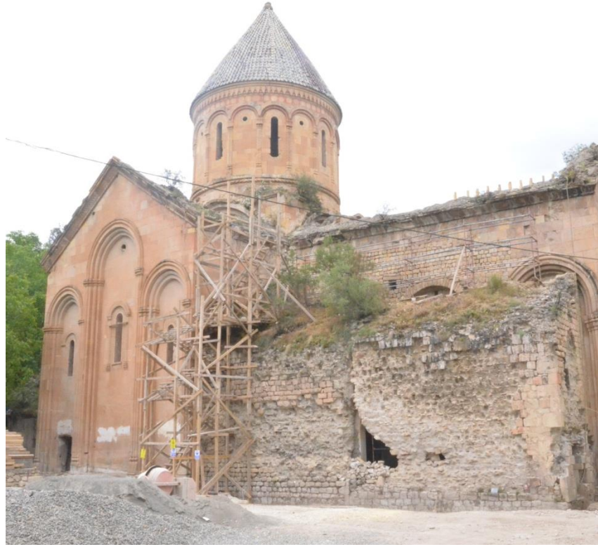
Resim 79: İşhan Kilisesi Restorasyonu, Malzeme ayrıntısı (G.Tiryaki, 2017)
