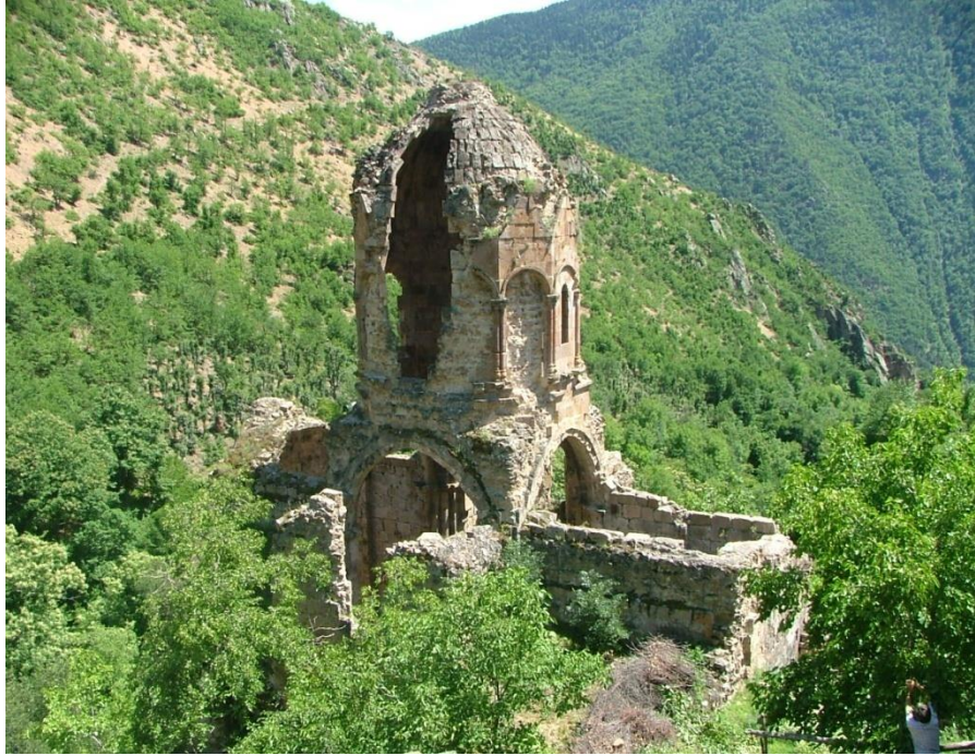
Resim 22: Pırmallı Porta Kilisesi Kubbe Kasnağı ( Artvin Vakıflar Müdürlüğü Arşivi, 2017)
