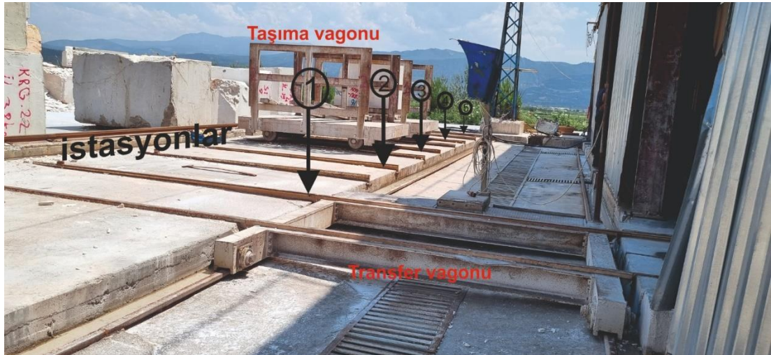
Şekil 5.9: Mermer fabrikasında transfer hattında çalışan taşıma, transfer vagonları
