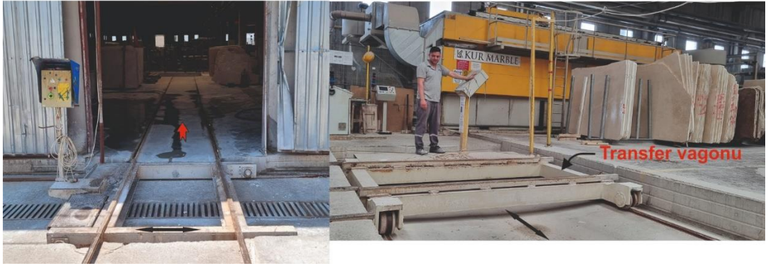
Şekil 5.12: Transfer vagonu görüntüsü
