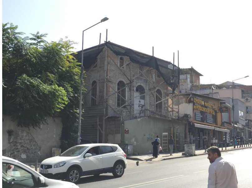
Fotoğraf 17: Asmalı Mescit restorasyon sırası genel görünüm.
