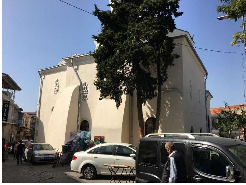
Fotoğraf 3: Hatuniye Camisi'ne genişletme çalışmalarıyla eklenen birimi destekleyen payandaların yer aldığı güney cephesi.
