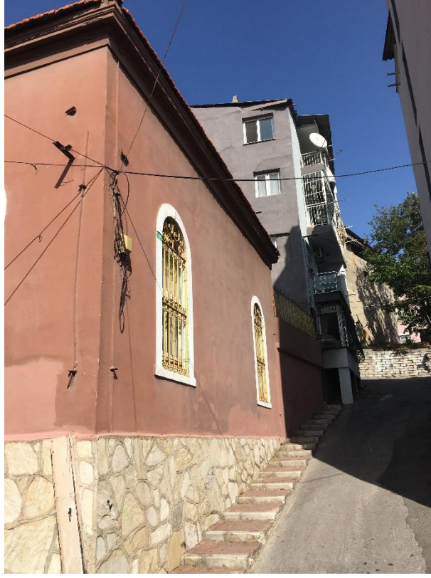
Fotoğraf 23: Nur Kamer/Kameriye Camisi sokak dokusuyla birleşik olan güney cephesi.
