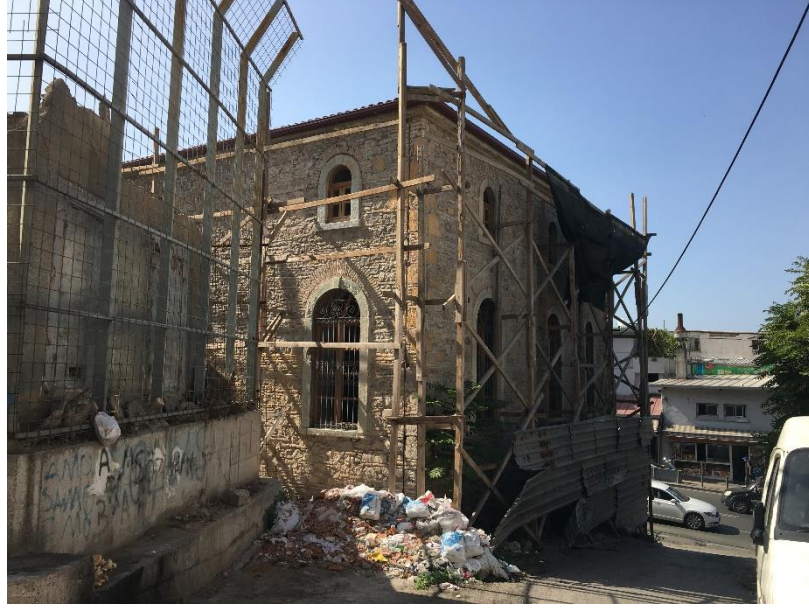
Fotoğraf 18: Asmalı Mescit restorasyon sırası genel görünüm.
