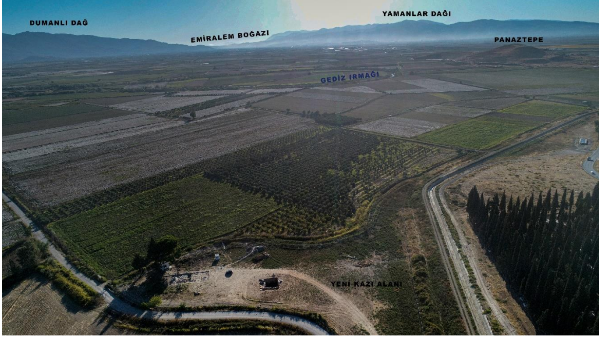
Foto 20. Yeni Kazı Alanı ve Panaztepe'nin Emiralem Boğazı'na doğru genel görünümü
