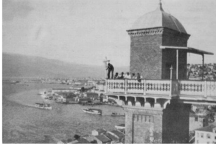
Görsel:18 Geçmişten bir görünüm, Asansör binası, İzmir
