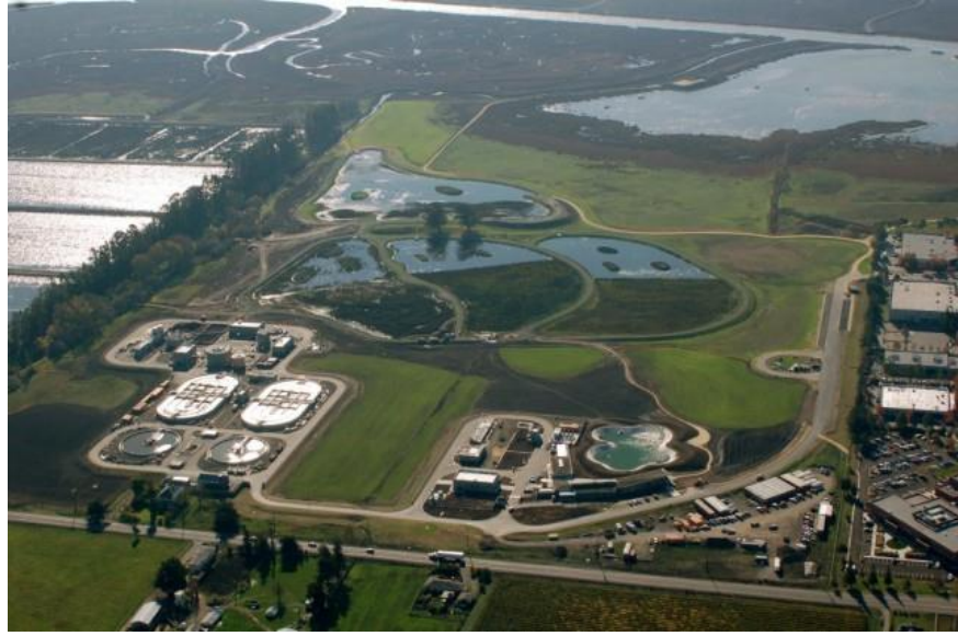
Resim 41: Patricia Johanson, Ellis Creek Su Geri Dönüşüm Sağlama Tesis, 2000, Petaluma, Kaliforniya
