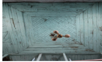
Fotoğraf 14: Kuzeyir Mahallesi Eski Camii harim tavan göbeğinden genel görünüm
