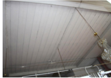
Merzifon Yeşilören Köyü Camii
